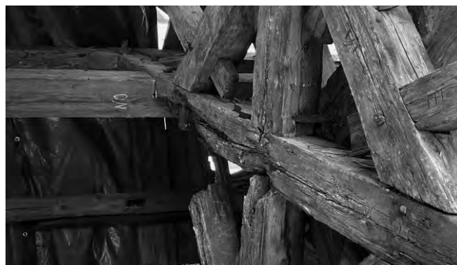
Schaden Kreuzkonstruktion
